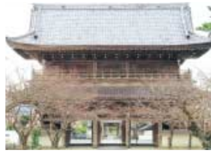
光明寺山門(本堂側より) 撮影・伊藤 昌平
